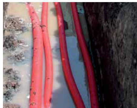
Рис.1 Применение кластеров для многоуровневой кабельной канализации.
