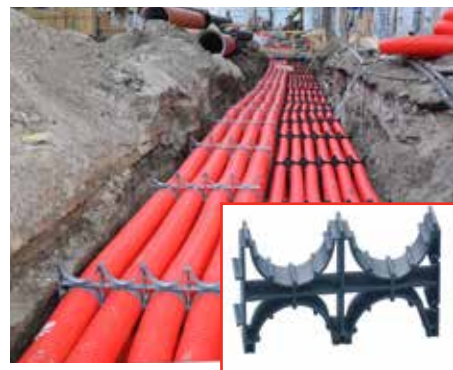
Рис.1 Применение кластеров для многоуровневой кабельной канализации.
