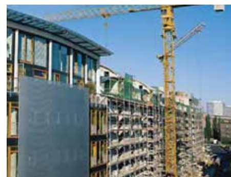
Строительство крупных торговых и складских комплексов
